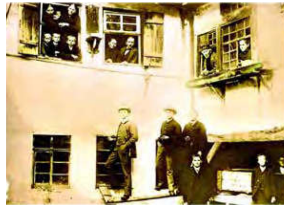
Wohnsituation in der Sindelfinger Altstadt zu Beginn des 20.Jh.
